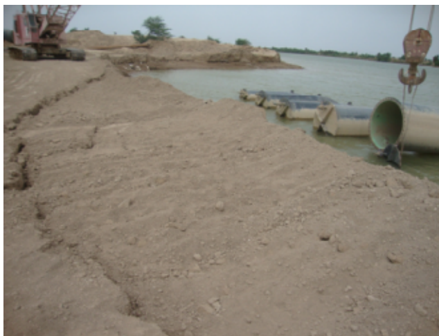
شکل بالا آمدن سیفون و نمایش خط لغزش
