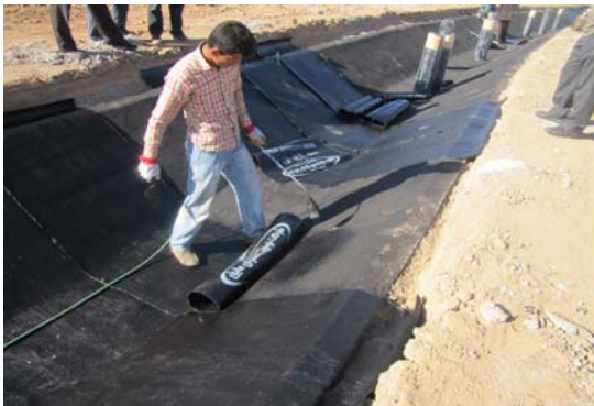
شکل (۵) - نصب PBGM روی بتن مگر اندود شده با پرایمر قیری
