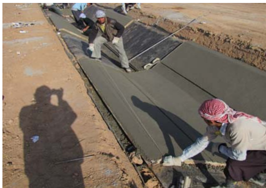
شکل (۷) - اجرای بتن لاینینگ روی PBGM
