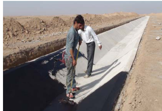
شکل (۴) - اجرای پرایمر قیری روی بتن مگر
