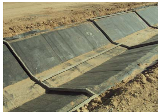
شکل (۶) - نصب قاب های فلزی جهت بتن ریزی لاینینگ بدون استفاده از میخ
