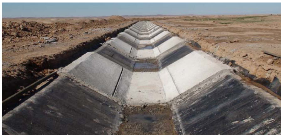
شکل (۱۰) - اجرای پانل های اولیه لاینینگ کانال روی ژئوممبران قیری اجرا شده
