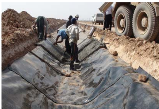
شکل (۳) - اجرای بتن پوششی روی ژئو ممبران پلی اتیلنی در بازه آزمایشی
