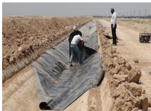
شکل (۲) - نصب ژئو ممبران پلی اتیلنی در بازه آزمایشی
