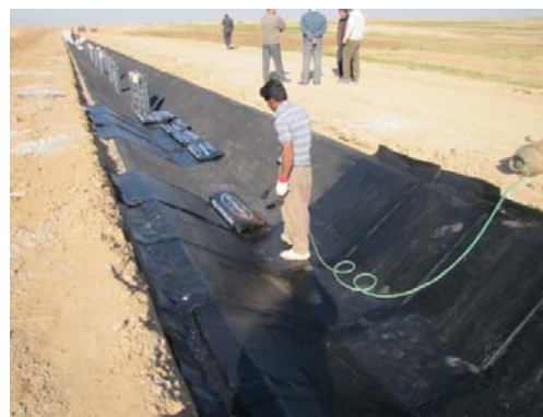
شکل (۴) - نصب عایق رطوبتی در بازه آزمایشی
