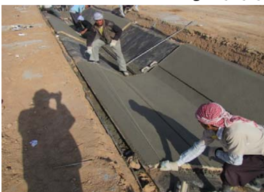
شکل (۵) - اجرای بتن پوششی روی عایق رطوبتی در بازه آزمایشی
