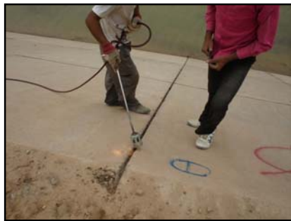
تصویری از عملیات تمیز کاری درزها
