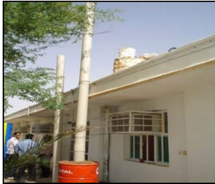
کارگذاری بارباکان نصب شده در لوله ۶ اینچ
