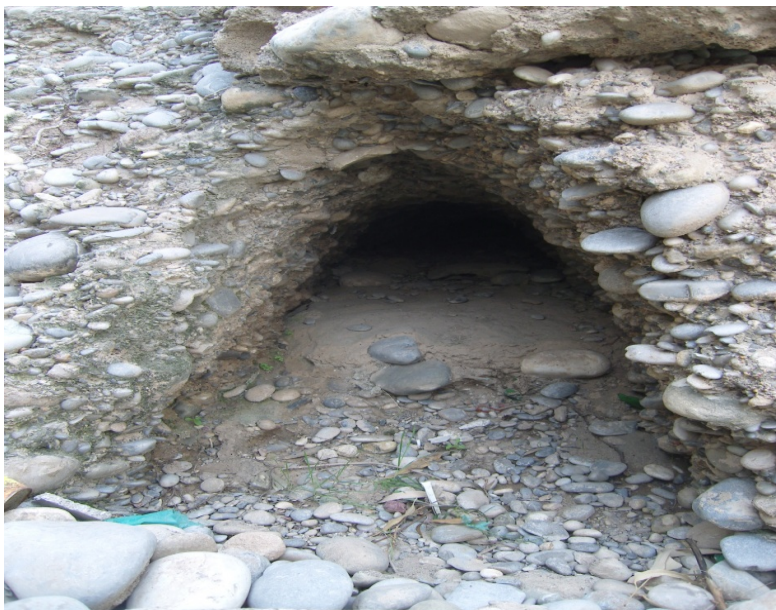
شکل ۳- سردهنه یکی از قنات‌های متروکه دزفول، منشعب شده از رودخانه دز
