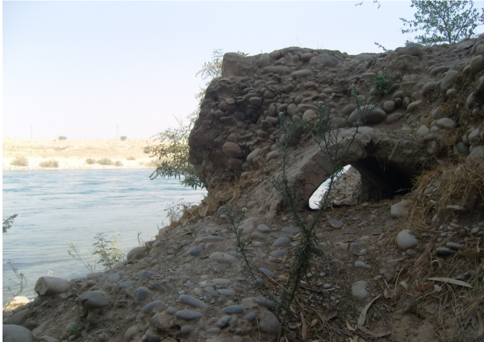
شکل ۶- سردهنه متروکه یکی از قنات‌های دزفول در کنار رودخانه دز
