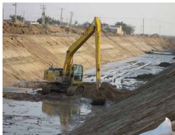
شکل (۲) لایروبی نیمه‌خشک
