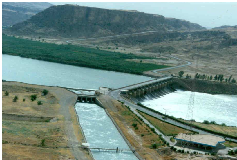
شکل ۱: تصویر صحرایی آبرگیرهای سد انحرافی گتوند در حال بهره برداری
