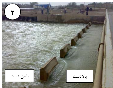
شکل (۲) و (۳) سرریز بهمنشیر قبل از مد (شکل (۲)) و بعد از مد (شکل (۳))
