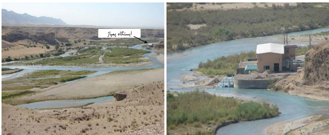
شکل (۲): نمایی از ایستگاه پمپاژ بنه‌باشت و رودخانه خیرآباد در بالادست ایستگاه
