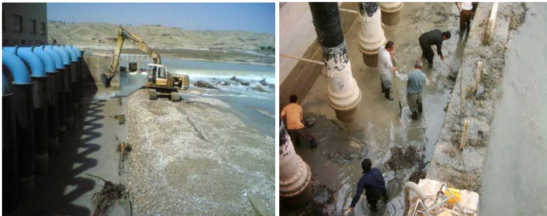
شکل (۴): لایروبی حوضچه مکش ایستگاه پمپاژ بنه‌باشت با استفاده از بیل مکانیکی و نیروی انسانی
