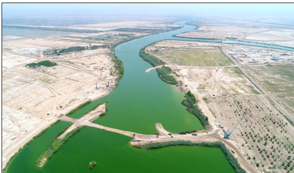
شکل ۲- اجرای بند خاکی مارد در پائین دست ایستگاه پمپاژ مارد
