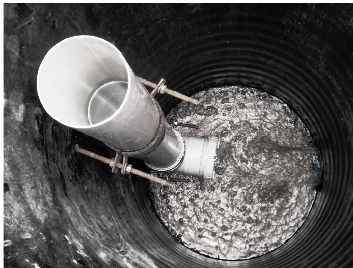
شکل ۲- جزئیات نصب سازه کنترل سطح ایستابی و سازه کنترل سطح ایستابی آماده بهره‌برداری
