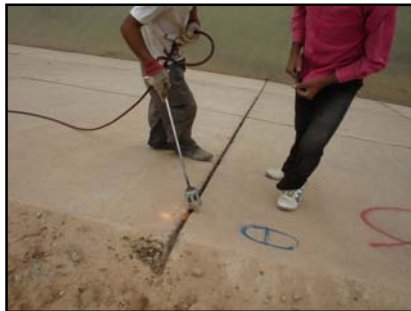
تصویری از عملیات تمیز کاری درزها
