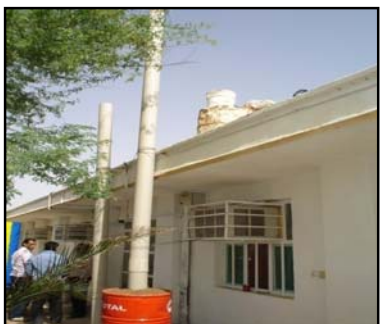
کارگذاری بارباکان نصب شده در لوله ۶ اینچ
