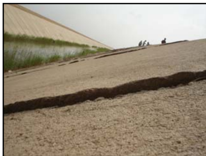
درزهای قدیمی اجرا شده با ماسه آسفالت و بیرون زدگی ماسه
