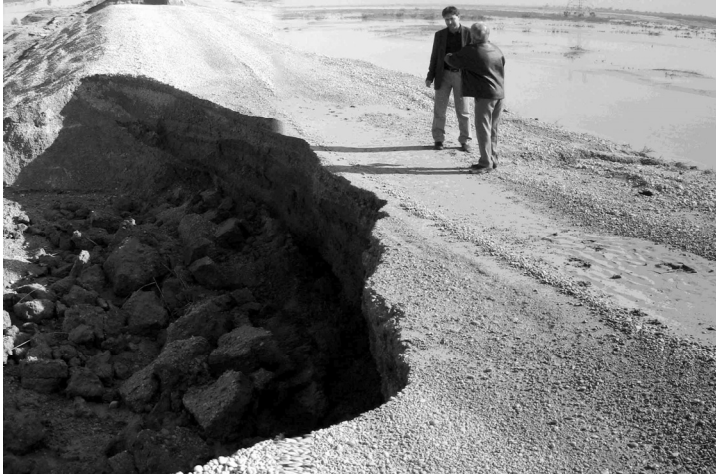
شکل ۹- شستگی کانال هادی و عدم شستگی فیوز به علت افزایش تراکم در اثر عبور و مرور ماشین‌ها
