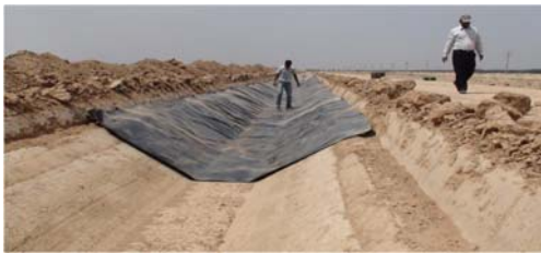
شکل شماره (۳) - نمایی از اجرای ژئوممبران HDPE
