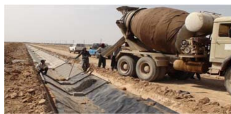
شکل شماره (۲) - نمایی از اجرای ژئوممبران HDPE
