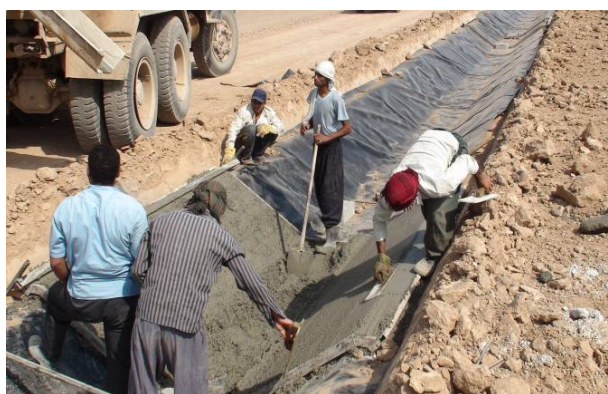
شکل (۳): بتن‌ریزی روی ورق‌های ژئوممبران
