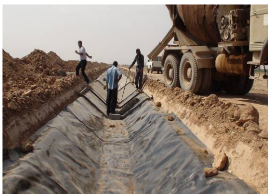
شکل (۲): چروک خوردگی ورق‌ها
