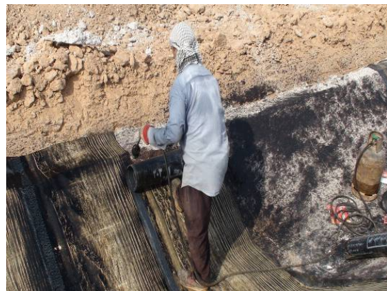
شکل (۵): نصب ایزوگام
