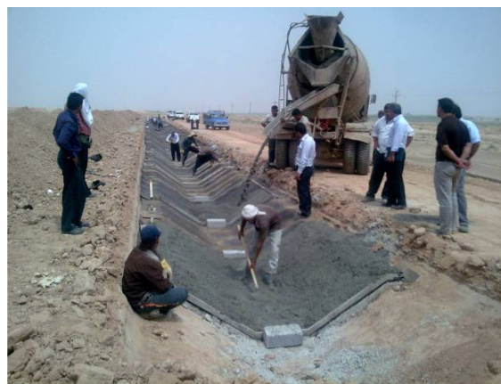
شکل (۷): لاینینگ روی ایزوگام
