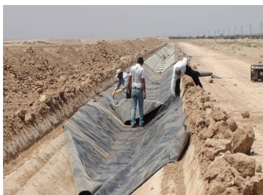
شکل (۱): پهن کردن ورق‌ها در مقطع کانال
