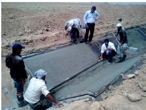
شکل (۷): لاینینگ روی ایزوگام
