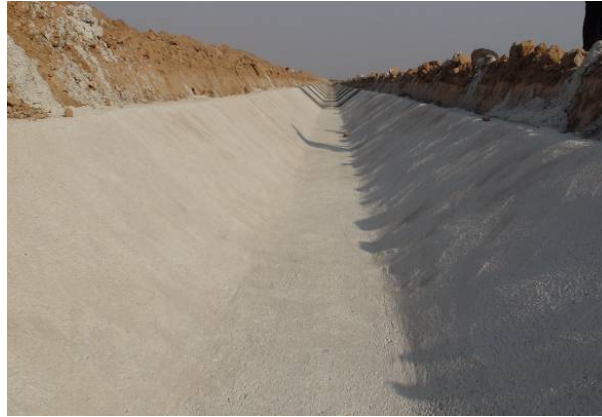
شکل (۴): بتن مگر اجرا شده
