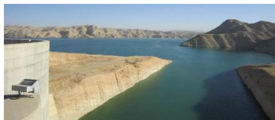
شکل ۹. قرارگیری طبقات مارنی و گچی سازند گچساران در مخزن سد جره، دید به شمال
