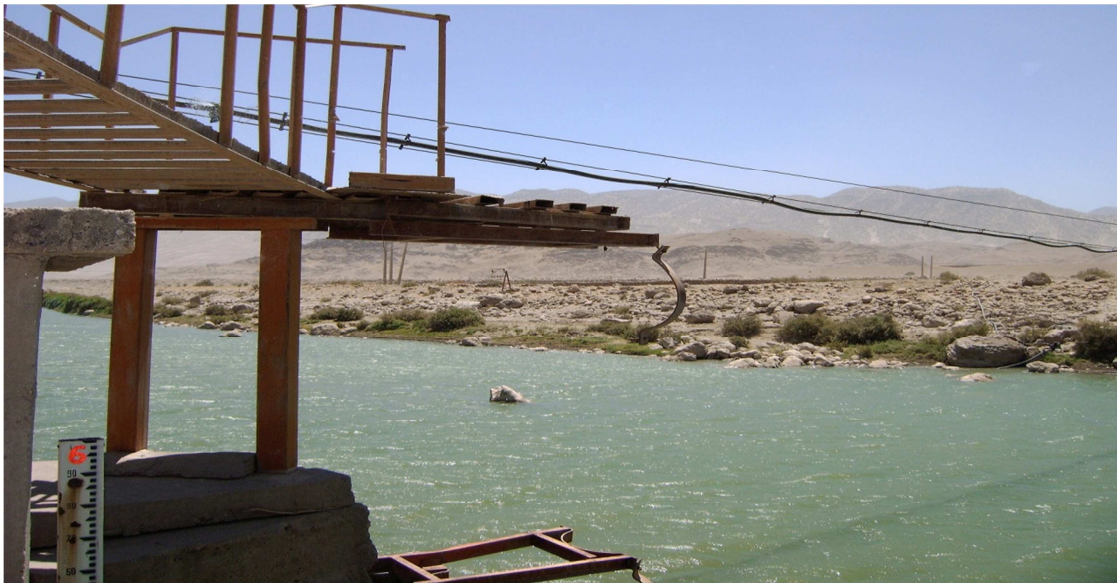
شکل (۱) تجهیزات ایستگاه هیدرومتری کرخه جلوگیری
