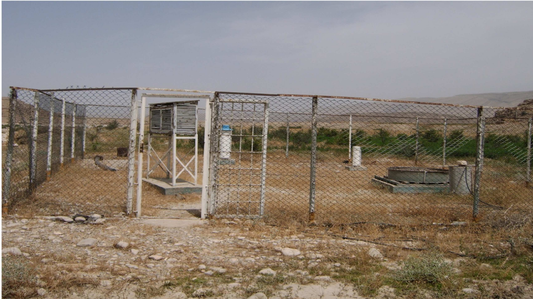
شکل (۲) تجهیزات ایستگاه هیدرومتری کرخه جلوگیر
