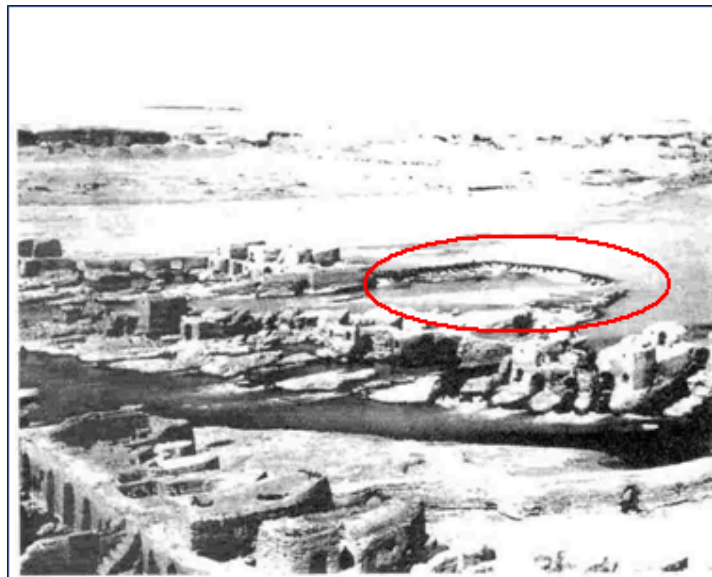
شکل ۷، نمایی از سد سبدهی ساخته شده (چو سله) برای آسیاب‌های آبی (سال ۱۳۰۸)
