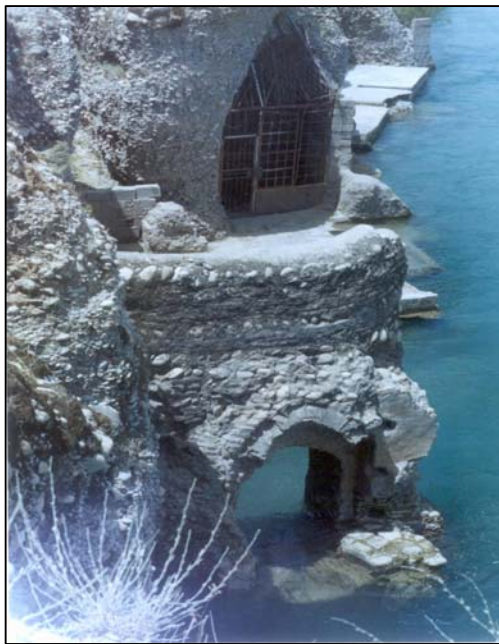
شکل ۱، بقایای دهانه آبگیر یکی از قنات های در دزفول
