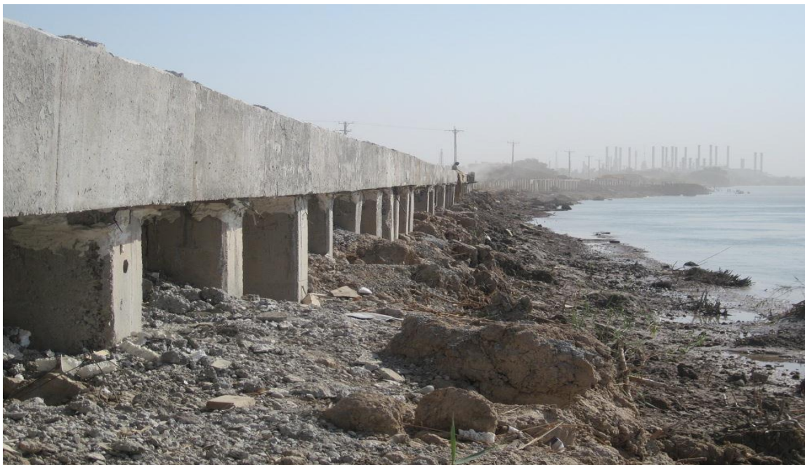
شکل (۱۱) - اجرای شناژ بتنی بر روی سر شمع ها پس از تخریب
