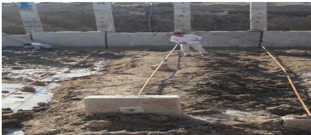
شکل(۱۰) - عملیات نصب تاندون
