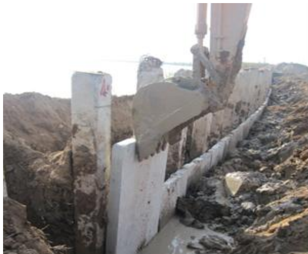
شکل (۸) - نصب سپر بتنی
