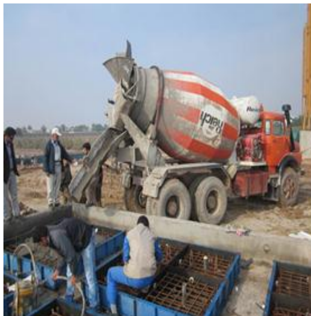
شکل (۴) - بتن ریزی سپرهای بتنی
