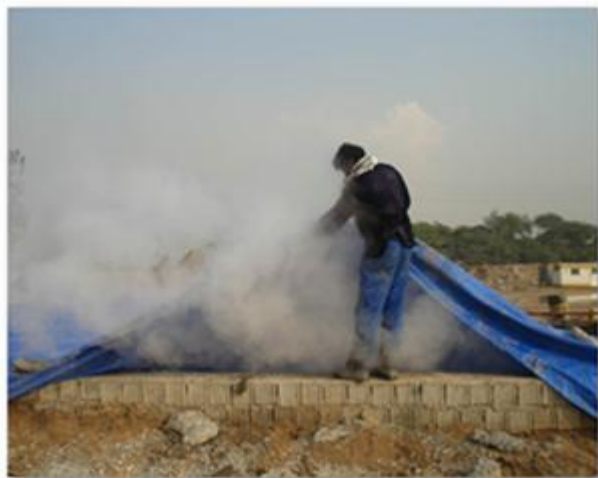
شکل (۶) - شمع کوبی شمع های بتنی شکل (۵) - بخاردهی شمع های بتنی
