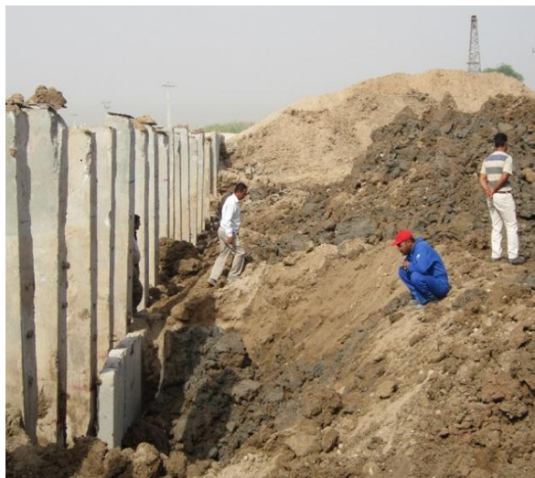
شکل(۹) - خاکبرداری مرحله ای و نصب
