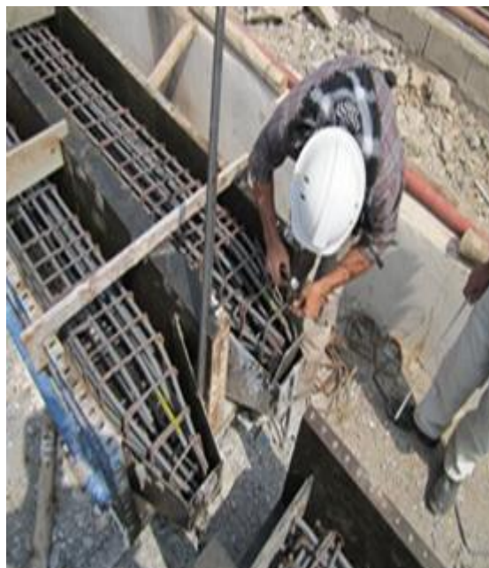
شکل (۳) - استقرار آرماتور شمع در قالب
