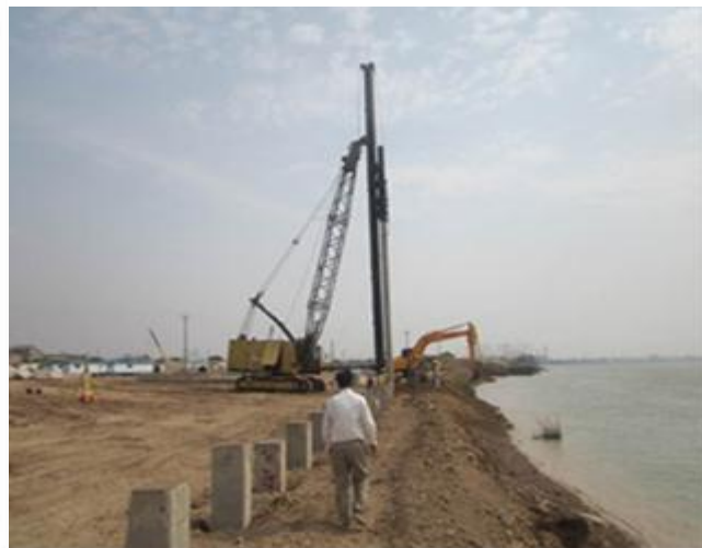
شکل (۶) - شمع کوبی شمع های بتنی شکل (۵) - بخاردهی شمع های بتنی
