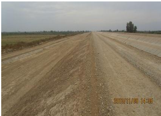
عکس شماره ۷: اصلاح شیب زنی و جاده سرویسها قبل از بهره برداری
