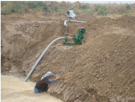
عکس شماره ۱۳ : نحوه تخلیه زهکش مجاور پاشنه کانال
