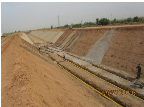
عکس شماره ۷: اجرای سیستم زهکشی کف کانال
