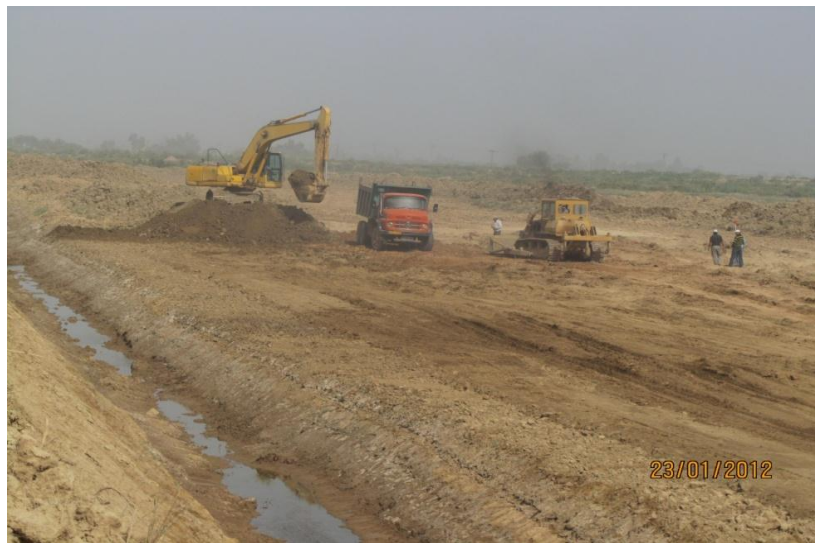
عکس شماره ۱۴ : انجام عملیات تعویض خاک پس از حفر زهکشهای مجاور پاشنه کانال
