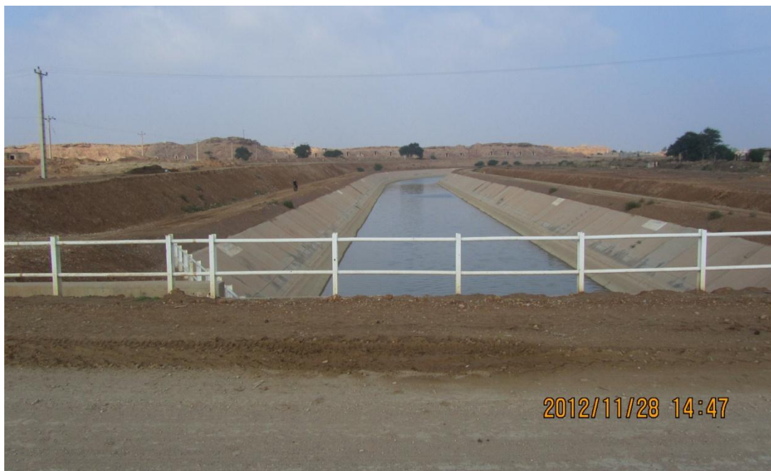
عکس شماره ۱ : نمایی از مقطع و ابعاد کانال انتقال آب دشت آزادگان
