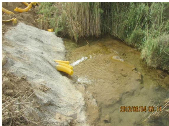
عکس شماره ۸: خروجی سیستم زهکشی کف کانال
