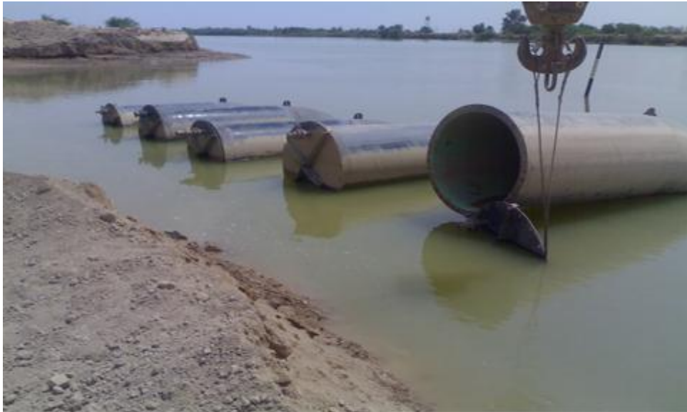
تصویر ۶: نصب قسمت دوم دستکها
