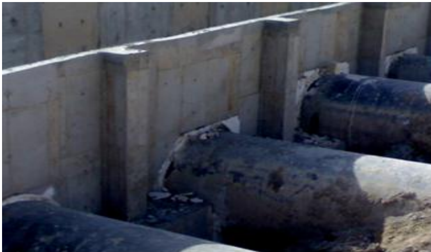
تصویر ۷: نصب قسمت افقی لوله‌ها از محل زانو تا سازه بتنی ورودی
