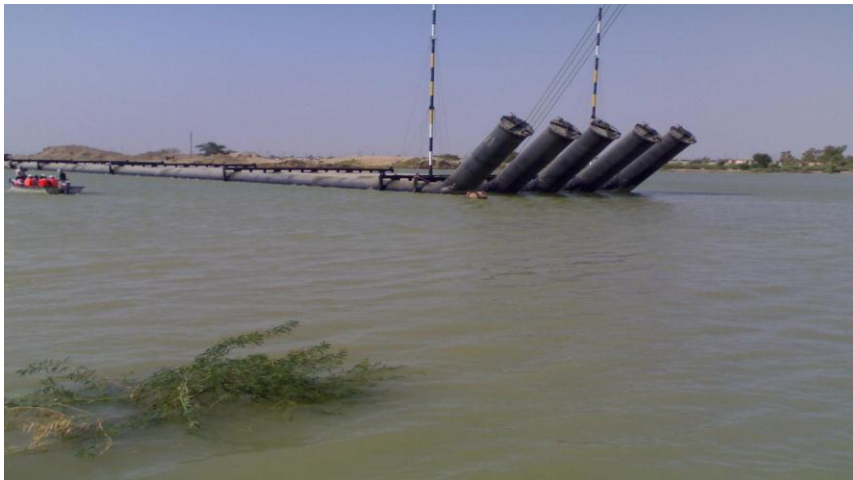
تصویر ۴: تصویر شناور کردن مجموعه سیفون در رودخانه و استقرار در محل مورد نظر
