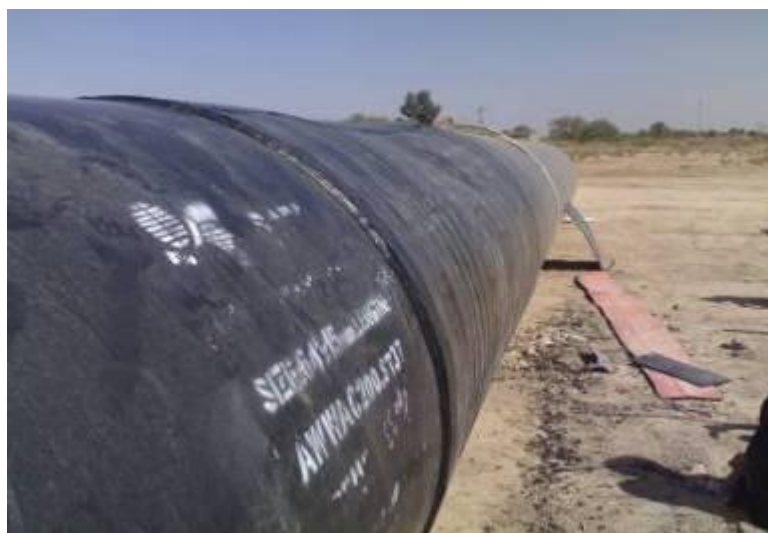
تصویر ۱۲: نمونه ساخت و مونتاژ اتصال با ورق پلی اتیلنی
