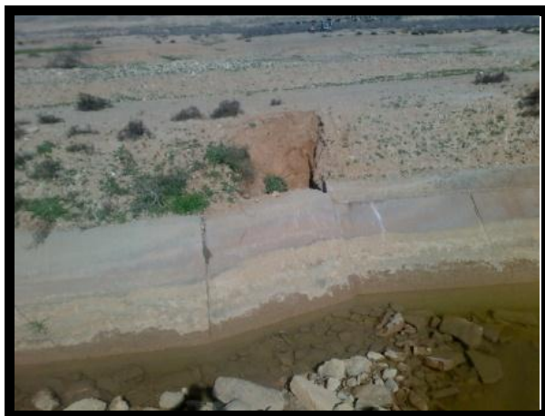
شکل شماره ۲- تخریب کانال ناحیه رامهرمز
