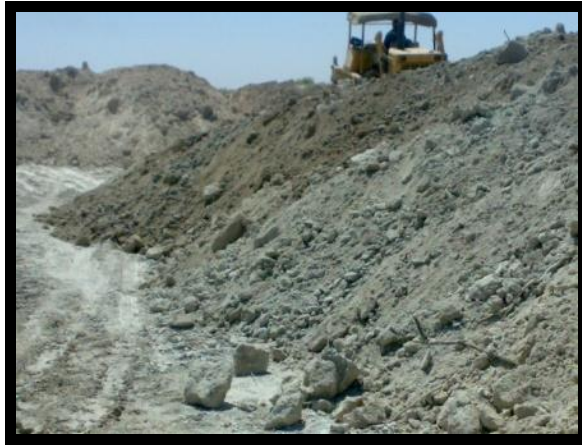
شکل شماره ۱- وجود گچ در مصالح منطقه رامهرمز
