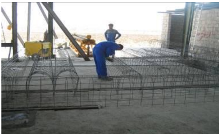
تصویر شماره ۶: شبکه آرماتورهای به کار رفته در کانالت
