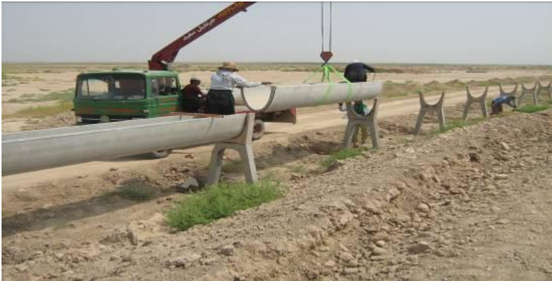
. تصویر شماره ۸: مراحل نصب و اجرای کانالت ها
