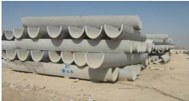
تصویر شماره ۲: کانالتهای پیش ساخته تیپ ۳۵۰ و نحوه دپوی آنها در کارگاه
