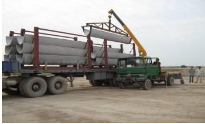
تصویر شماره ۷: بارگیری و حمل کانالت ها به خط پروژه
