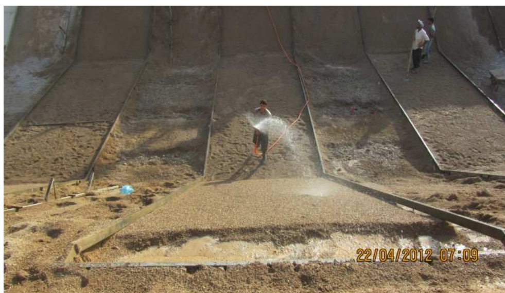
شکل ۴ - آبپاشی فیلتر بدنه کانال به منظور حصول تراکم بهتر
