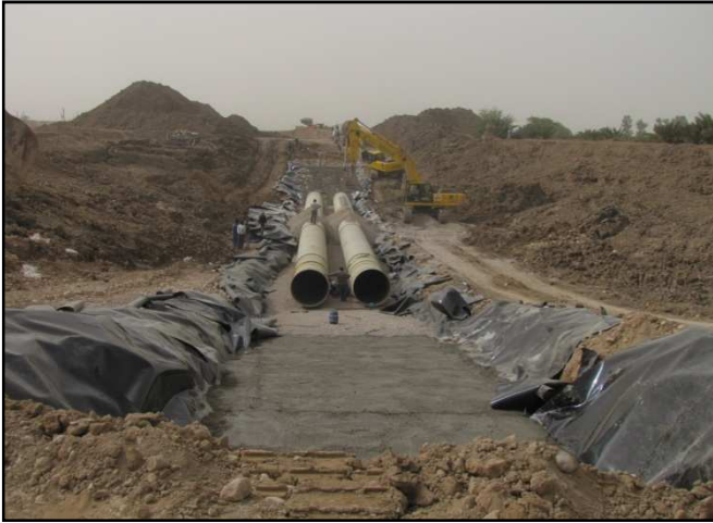
شکل (۵): لوله گذاری با استفاده از پوشش شنی و محافظت لایه ژئوممبران
