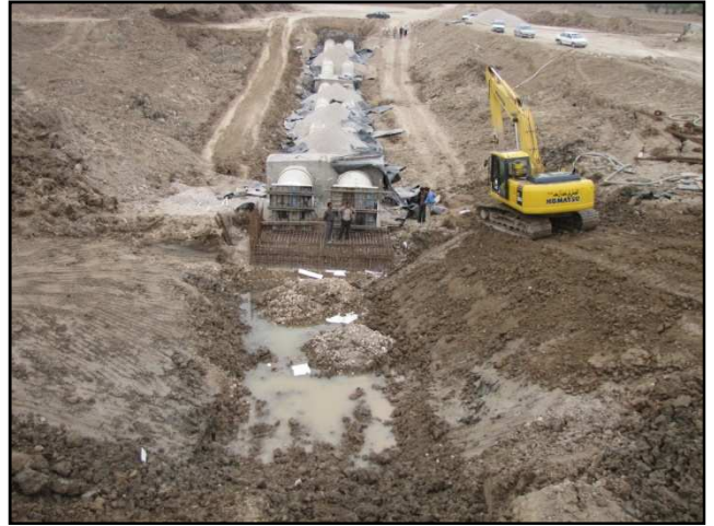
شکل (۵): لوله گذاری با استفاده از پوشش شنی و محافظت لایه ژئوممبران
