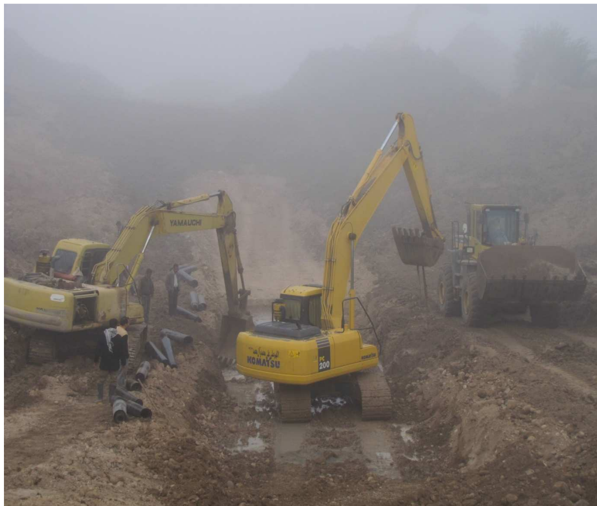
شکل (۴): پی کنی سازه در شرایط آب و هوایی نامساعد و سخت (آلودگی هوا)
